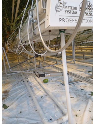
Figuur 1: Overzicht van de geïnstalleerde buistypes. Links: vinnenbuis, Midden: PEX-buis met diameter 20mm, Rechts: PE-buis met diameter 40mm
