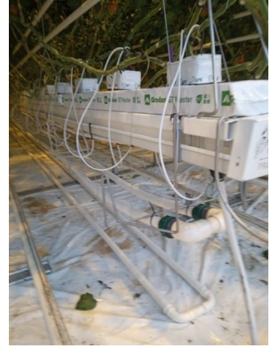
Figuur 1: Overzicht van de geïnstalleerde buistypes. Links: vinnenbuis, Midden: PEX-buis met diameter 20mm, Rechts: PE-buis met diameter 40mm
