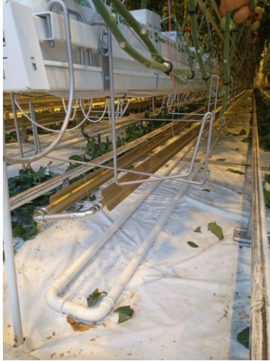
Figuur 1: Overzicht van de geïnstalleerde buistypes. Links: vinnenbuis, Midden: PEX-buis met diameter 20mm, Rechts: PE-buis met diameter 40mm
